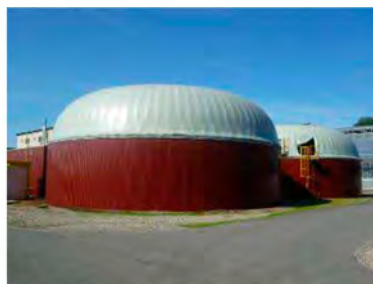
円柱型メタン発酵槽
