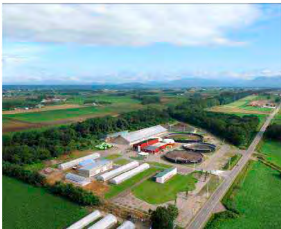
鹿追町環境保全センター全景
