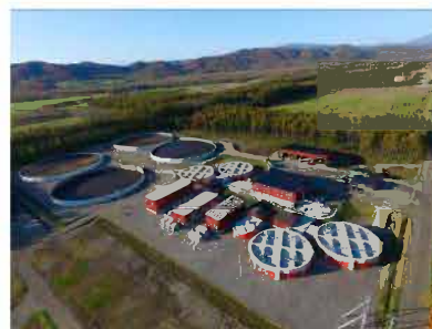
町内2基目の 集中型バイオガスプラント
