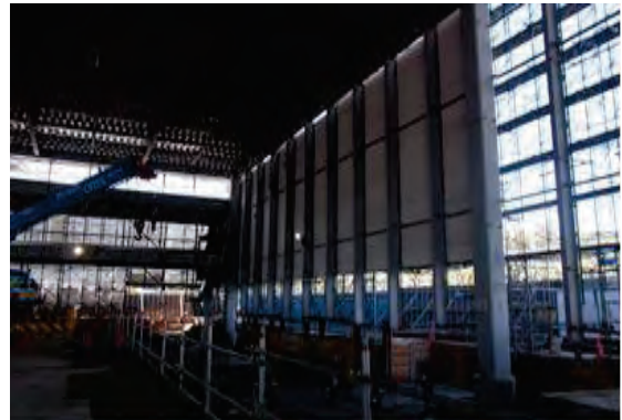
ALC外壁施工状況
