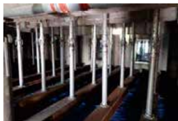
図-2 階上解体のための構造体補強H型鋼、サポートを設置
