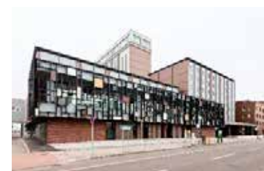
図-6 減築、改修工事了
