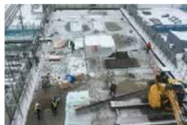
図-5 減築作業が終了し、順次H型鋼を撤去
