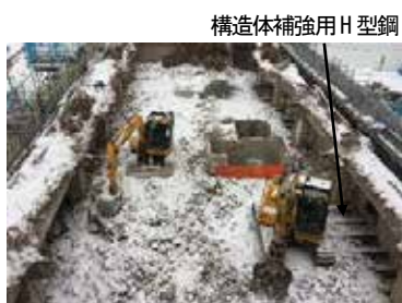
図-4 床への荷重回避のため、H型鋼の上で解体作業実施
