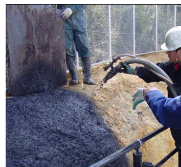
法面緑化材の吹付け施工
