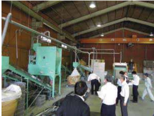
破砕機の全体像
