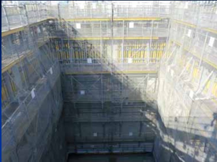
免震コアウォール doka型枠システム使用 44回型枠転用実施 14,000 \text{m}^2 木製型枠削減
