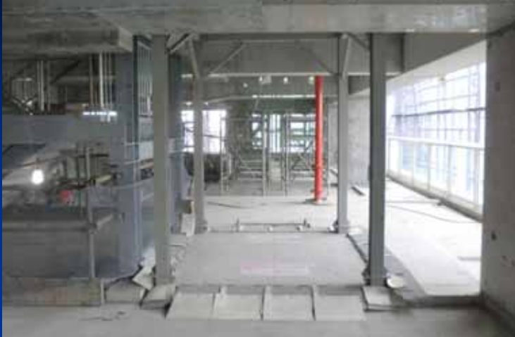
【当現場の鉄骨ステージ】
