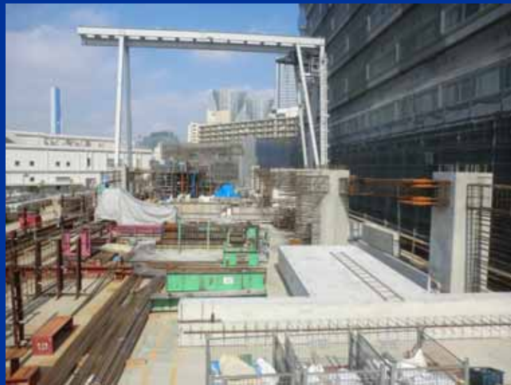
コア柱・屋上ゴンドラ基礎PCa化 7,000 \text{m}^2 木製型枠削減
