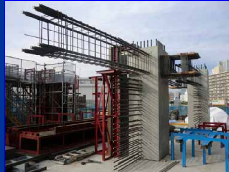
コア柱・屋上ゴンドラ基礎PCa化 7,000 \text{m}^2 木製型枠削減
