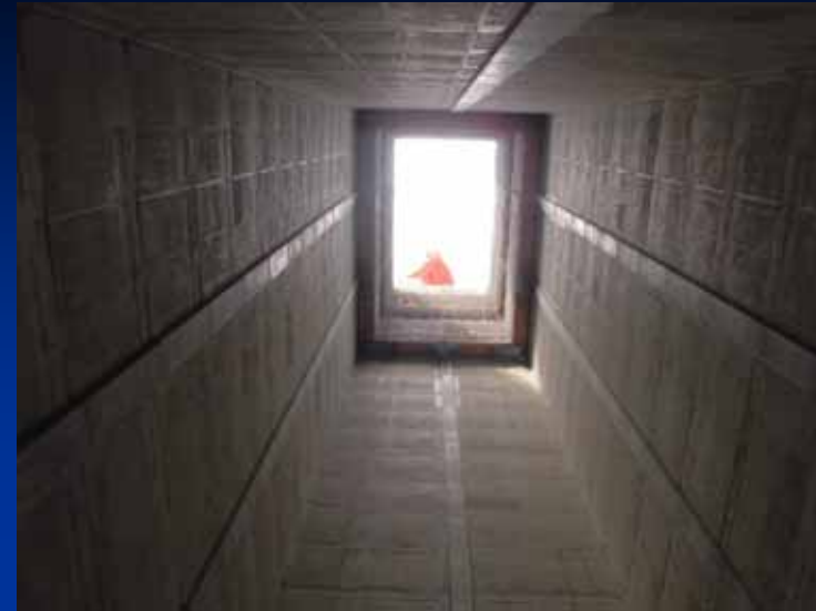
免震コアウォール doka型枠システム使用 44回型枠転用実施 14,000 \text{m}^2 木製型枠削減
