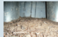
流入部 堆積状況
