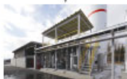
② 水素製造装置 触媒環境下でメタンガスと水蒸気を反応させて水素を発生させます。
