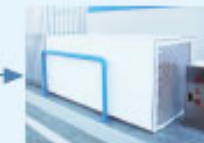
③ プレクーラ（冷却装置） 70MPaで供給する水素は直前で冷却します。
