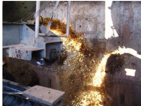
濃縮下水汚泥
