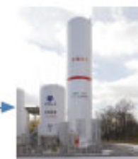
③ 水素ガスホルダー 水素を貯蔵し、製造量と利用量のバランスを調整します。
