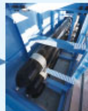
② 蓄圧器ユニット 水素を高圧のまま貯蔵します。
