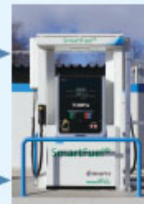
④ ディスペンサ（水素充填機） 2通りの圧力で水素を供給します。
