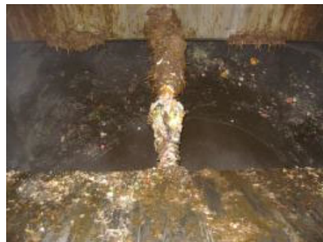
生ゴミのバイオガス化
