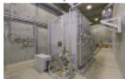
① バイオガス精製設備 バイオガスから分離膜でメタンガスを抽出します。
