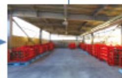
⑤ カードル充填場 種豚本のボンベが菜になったカードルに水素を充填します。
