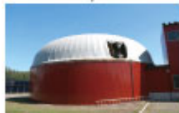
既存メタン発酵施設 家畜ふん尿を発酵させ、バイオガスを発生させます。
