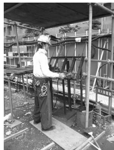
高層棟の床版コネクター筋のメッシュ化（現場製作）
