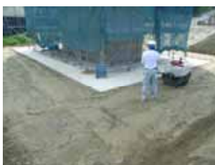
<構造物埋戻し利用状況>
