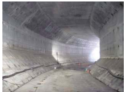
躯体構築完了
