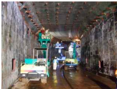
セグメント撤去状況
