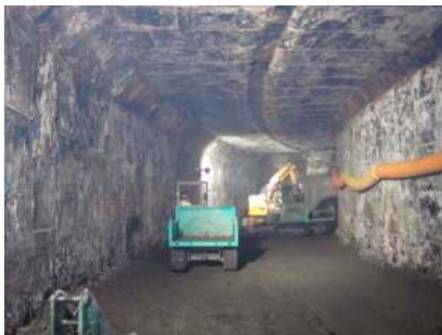
内部掘削状況
