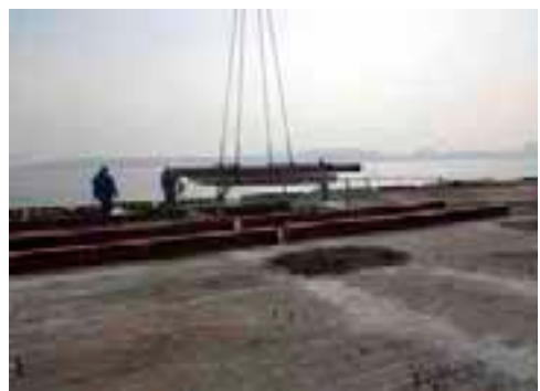
既設床版撤去状況
