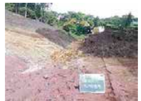
チップ材敷設状況
