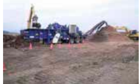
伐採材の破砕状況
