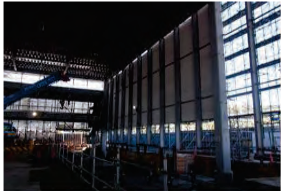
ALC外壁施工状況
