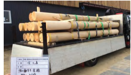
柱プレカット搬入状況
