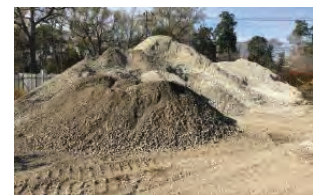
再生碎石を現場内敷均し
