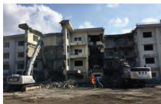
既存建物解体
