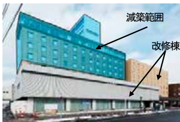
図-1 減築工事範囲（工事前）
