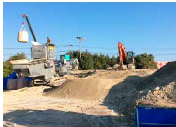
コンクリート魂と建設汚泥の場内中間処理実施状況
