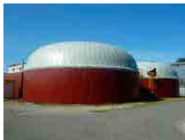
円柱型メタン発酵槽
