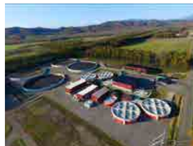
町内2基目の集中型バイオガスプラント
