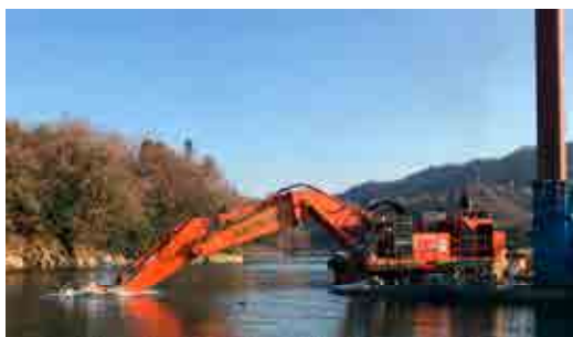
相模貯水池での浚渫状況
