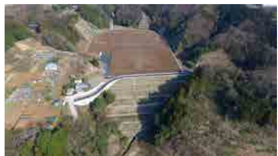
完成したグラウンドの全景
