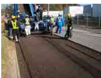
写真-2 CAE施工状況
