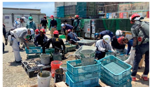
写真 職長会と一体となった産廃分別状況
