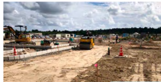
写真 現場発生土を利用した盛土状況
