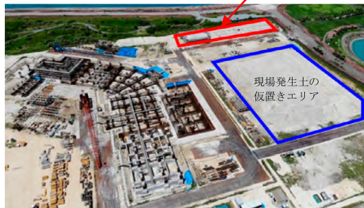
写真 建設汚泥・発生土の施工中の状況
