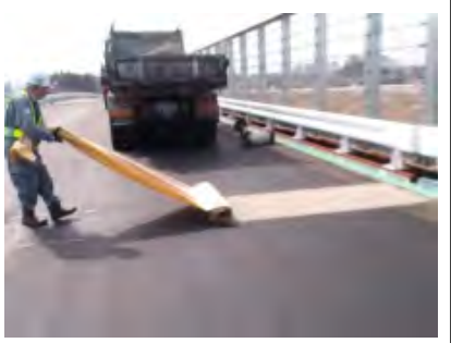
図-4 G・Asシート敷設状況
