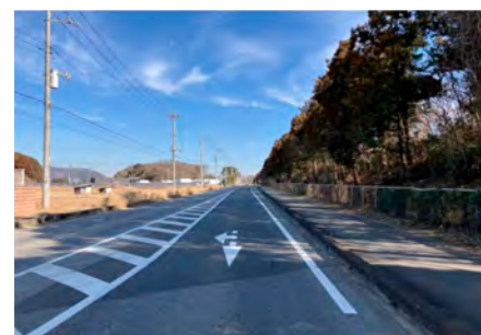
写真2 CO 2 固定化再生路盤材を利用したアスファルト舗装（検証中）
