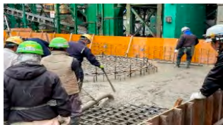
「サイロ基礎」打設状況
