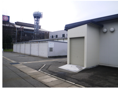
エコステーション（奥）と計量室（手前）
