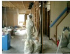
▼ リフォーム施工現場での分別作業
