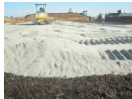
地盤改良増粒砂
