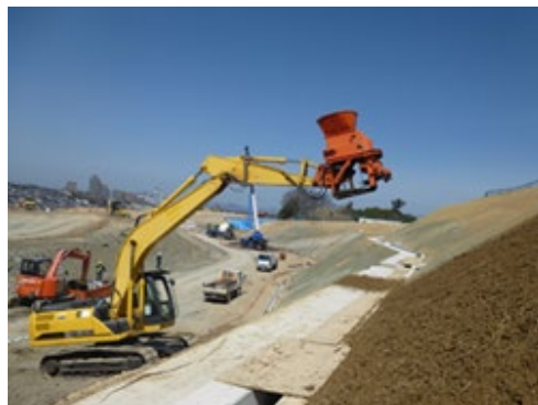
施工状況（標準施工システム）
