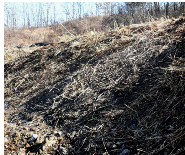
現地発生土・表土の集積
