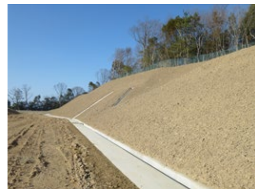
施工後法面状況
