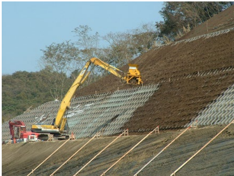
ロングアーム方式 (法面2段 10m)
