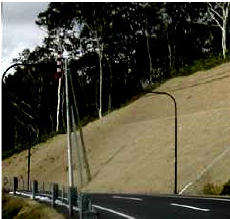
施工直後法面状況
