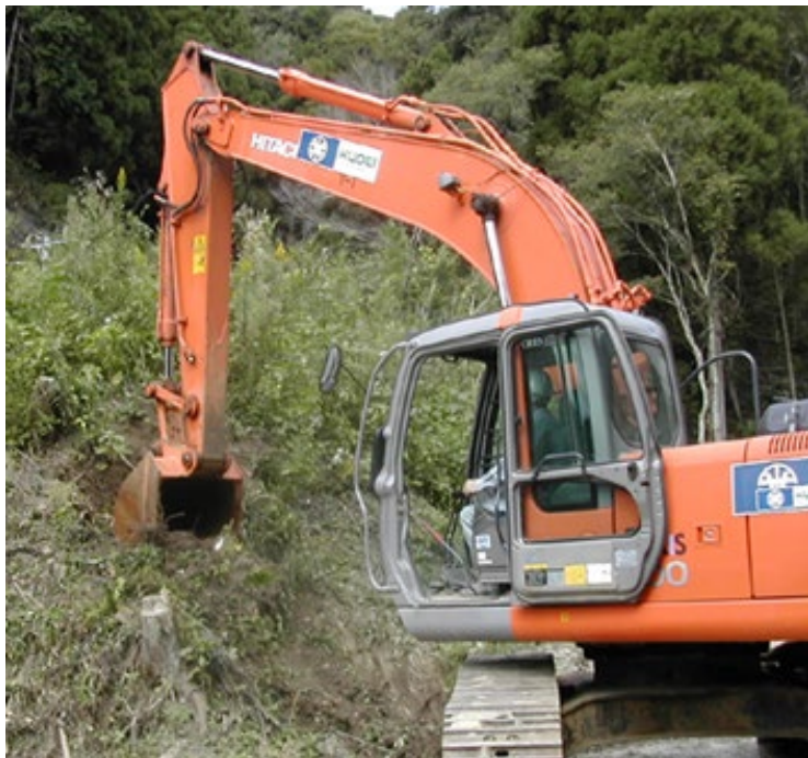
現地発生土・表土の採取
