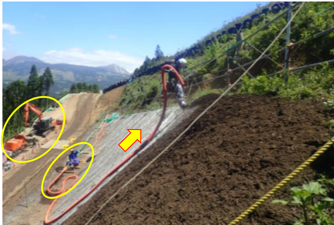
ポンプ圧送方式 吹付状況
