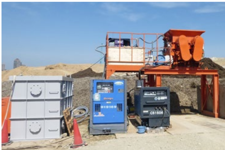
生育基盤材料の製造 定置式小型プラント 0.5 m 3
