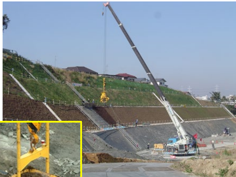
クレーン方式 (30m 50t 使用時)
