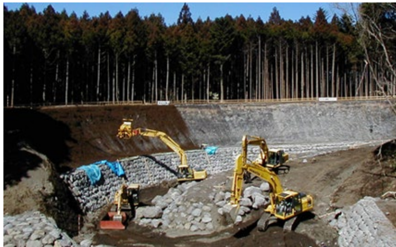
砂防工事における施工状況
