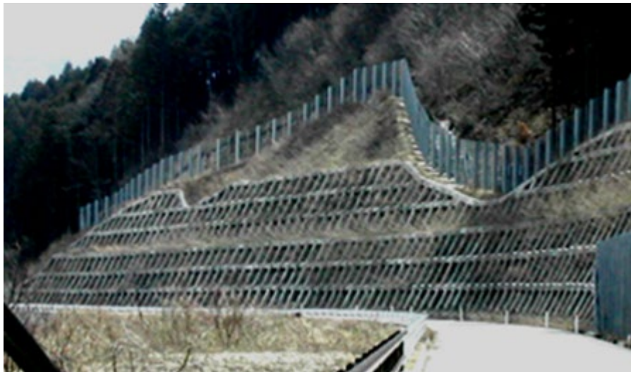
施工前法面状況 法面勾配 1 : 0.5
